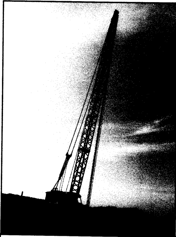
Imagen N° 03.- Equipos pesados paralizados.
